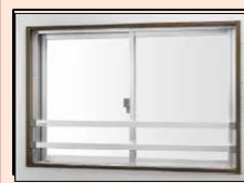
転落防止の手すりの設置
